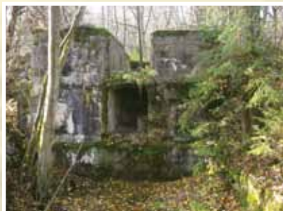
Betonowa konstrukcja kuźni.
